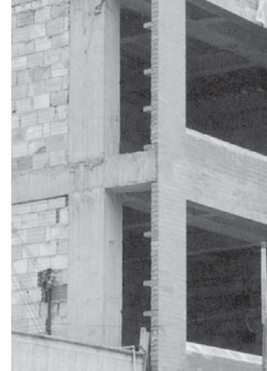
Edificio en construcción. Vivienda en Bogotá. Foto: Rafael Villazón.
