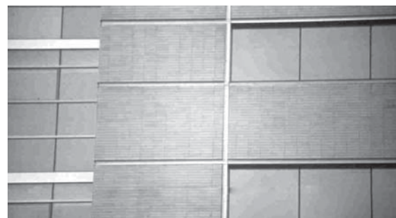
En países de alto riesgo sísmico como Chile, el lenguaje de la subestructura de la fachada ya se ha incorporado al repertorio formal y hace parte integral de la concepción del edificio. Foto: Rafael Villazón.
