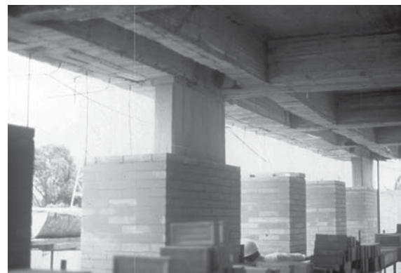
Arq. Konrad Brunner – Centro recreativo familiar Compensar – Bogotá. La modulación de los machones de ladrillo a la vista de la fachada, priman sobre el orden establecido por la estructura aporricada de concreto. Al finalizar la obra no se percibirá la ubicación de la estructura, ya que la forma del cerramiento será predominante.
