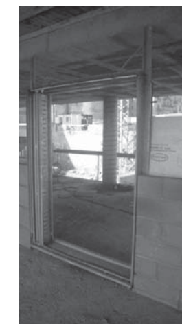
Al cerrar la ventana se observa el manejo de los goteros, traslazos y canales de conducción necesarias para que funcione adecuadamente, independiente de su material de fabricación. Foto: María Luisa Vela.
