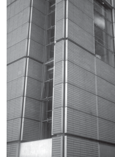
IRCAM, Renzo Piano, París. La práctica de "enchapar" el borde de los entrepisos para simular que la fachada es una piel continua ha sido muy criticada por diferentes académicos: problemas de estanqueidad, de decoloración y de estabilidad frente a empujes laterales.
