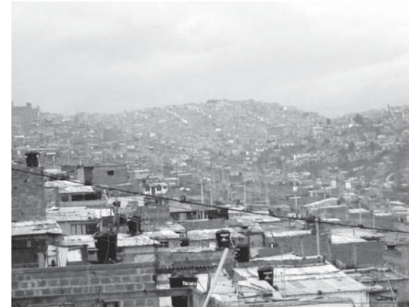
Barrios del sur de Bogotá: "mares" de viviendas sin servicios, ni espacios públicos apropiados.
