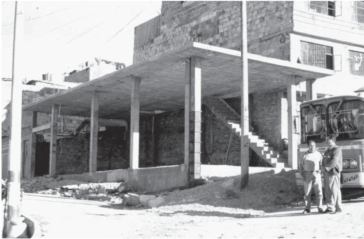
Sistema constructivo de vivienda informal en algún lugar de Bogotá
