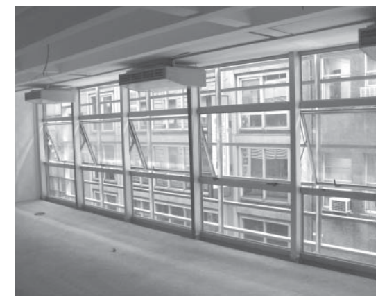
Detalles del sistema de parasoles de aluminio con vidrios de seguridad utilizados en las ventanas del edificio. En cada piso se generan rejillas metálicas que permiten limpiar los vidrios e incluir plantas que mejoran el clima interior.
