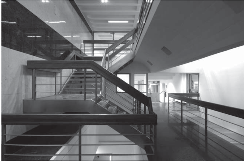
Escalera general; las mejoras aplicadas a los espacios de circulación, permiten una mejor evacuación en caso de emergencia.
