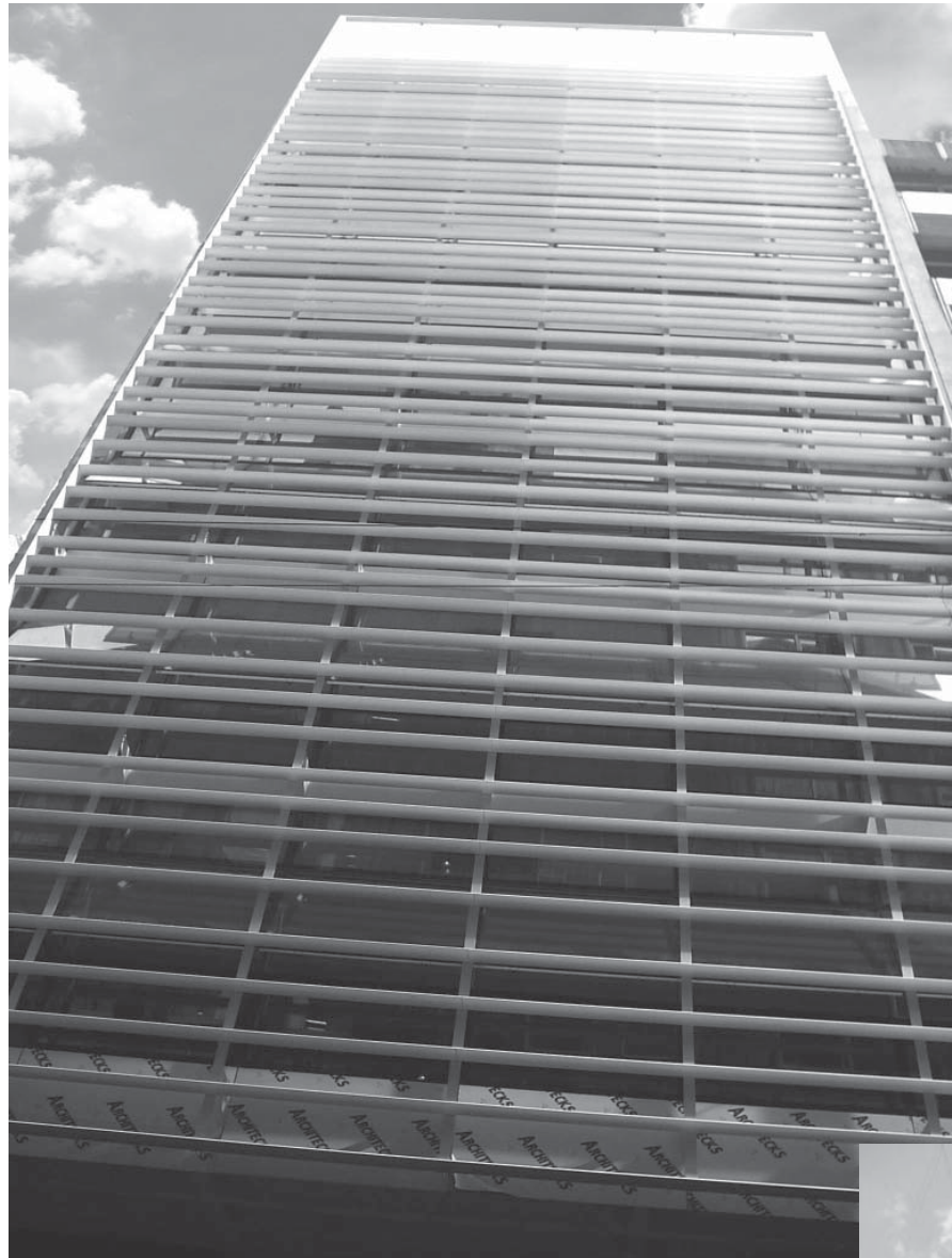
Caja de Valores de Buenos Aires: Nueva fachada en la que se aprecia como el edificio se ventila e ilumina naturalmente.
