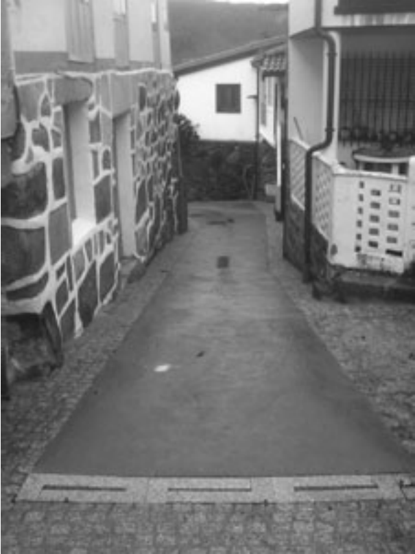
Camiño da Fonte ó remate dos traballos para o novo pavimento.
