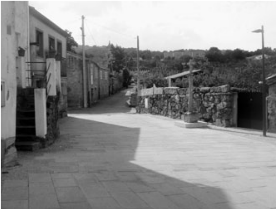
Rúa da Igrexa ó remate da colocación do novo pavimento.
