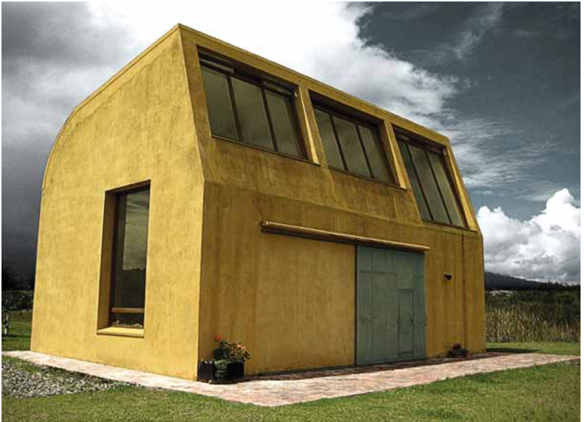
Vista general frente al acceso.
