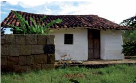
18. Detalle del muro de cerramiento de la ducha.
