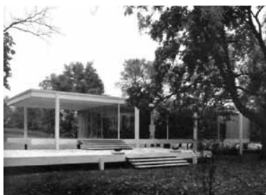
3. Ludwig Mies van der Rohe. Casa Farnsworth. Plano. Illinois. 1945-51. Fuente: David Spaeth, Mies van der Rohe, Idea Books , (AP World Wide Photos: 214. 1985); 122.
