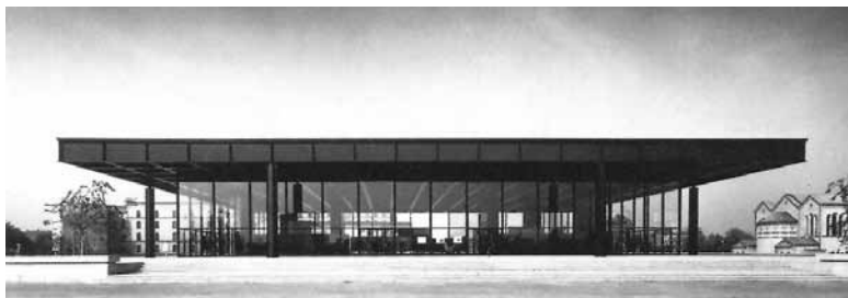
2. Ludwig Mies van der Rohe. Neue Nationalgalerie. Berlín. 1962. Foto Balthazar Korab, Fuente: Peter Carter, Mies van der Rohe at Work (Londres: Phaidon Press, 1999)
