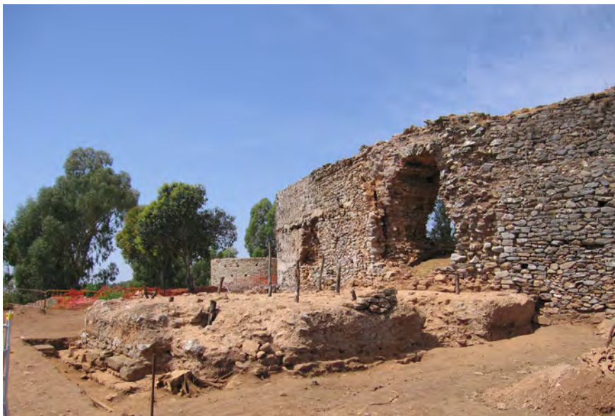
Figura 5.- Foto de la plataforma desde el este.
