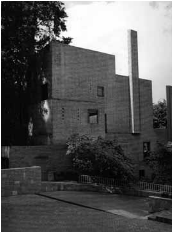
Figura 1. Detalle de la fachada norte. Fuente: Archivo Ricardo Castro.
