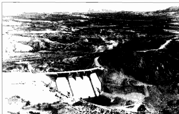
FIG. 4. Presa del Moro (5,6 hm 3 ). Las presas recientes de ramblas obedecen a la necesidad de controlar aguaduchos fulminantes y, en ocasiones, colosales (Confederación Hidrográfica del Segura).
