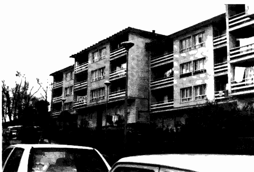
Fig. 7. Vista parcial del grupo de 40 viviendas de San Vicente de la Barquera (1990).
