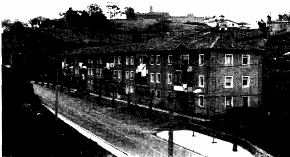
Fig. 4. Grupo de 28 viviendas de Comillas (1990).
