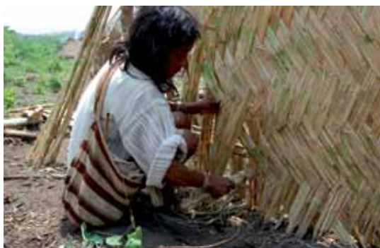
Figuras 11 y 12. Trenzado en caña boba para cerramientos y amarres en bejucos.
