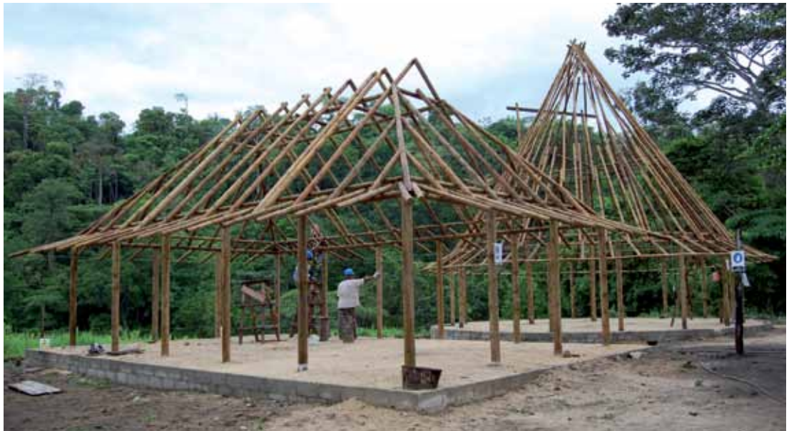
Figura 23. Cocina y comedor en construcción.
