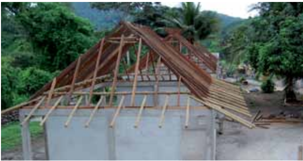
Figura 24. Cubierta de aulas.
