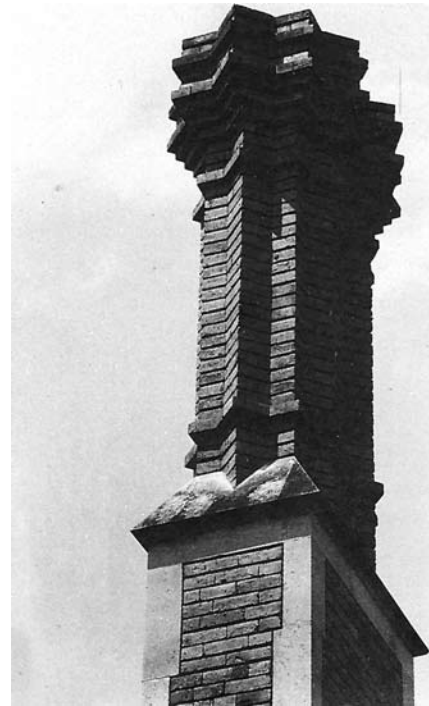
10b. Detalle de Chimenea. Fotografía de Sergio Trujillo Jaramillo.
