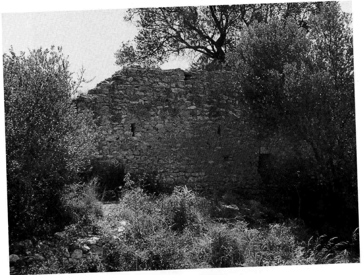
Vista del castell dels Montgons
