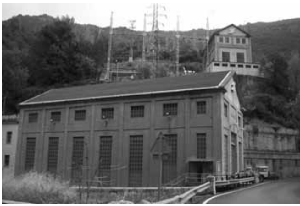
Figura 7. Central eléctrica del Poqueira
