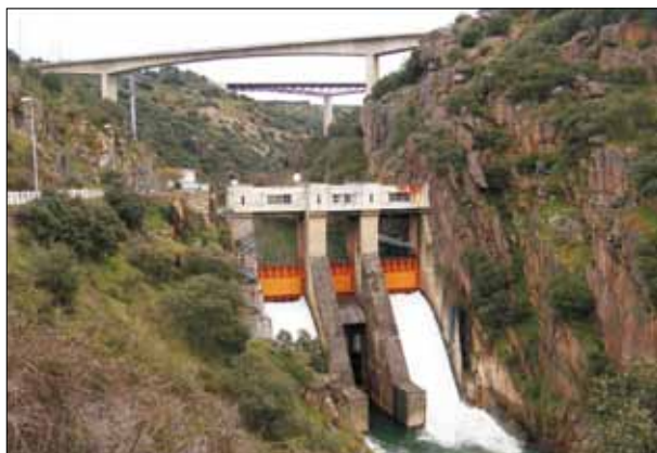
FIG. 10. Presa de Fuente del Azufre.
