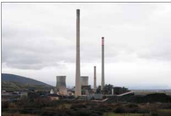
FIG. 9. Central térmica de Compostilla II.
