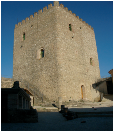
Torre del Homaje reconstruida
