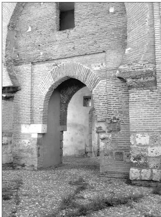
Fig. 26. Otro aspecto de la puerta de las Huelgas.
