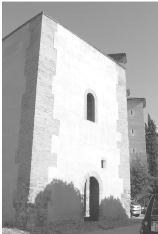
Fig. 30. El hueco que se abrió tardíamente en su frente oriental, alteró su función y debilitó la puerta de las Huelgas.
