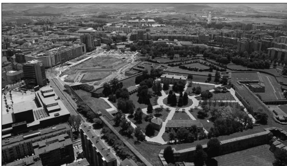
Figura 14 a y b. M. Blasco; L. Tabuenca y M. Sagastume, Proyecto y ejecución de recuperación del revellín de Santa Lucía
