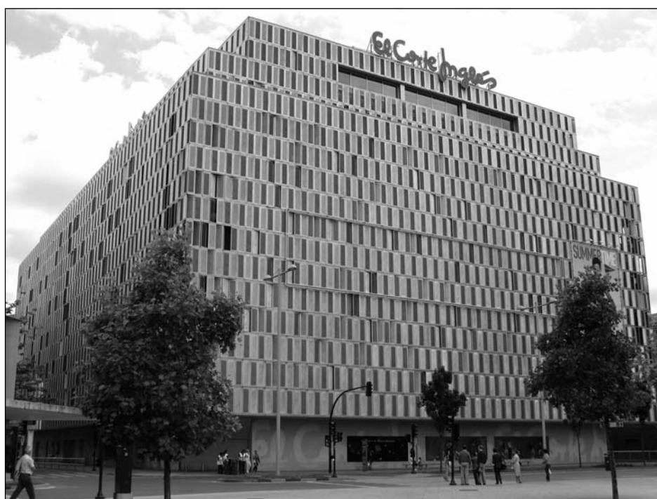
Figura 22. Edificio de El Corte Inglés en Pamplona
