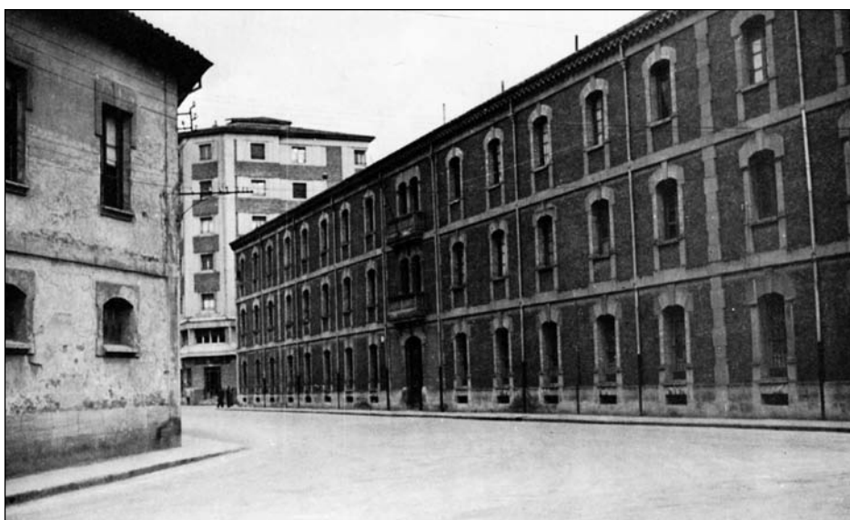
Figura 7. Cuartel de Intendencia en la calle Estella, año 1953 (AMP)
