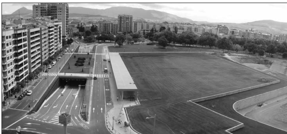
Figura 16. Estación subterránea de autobuses
