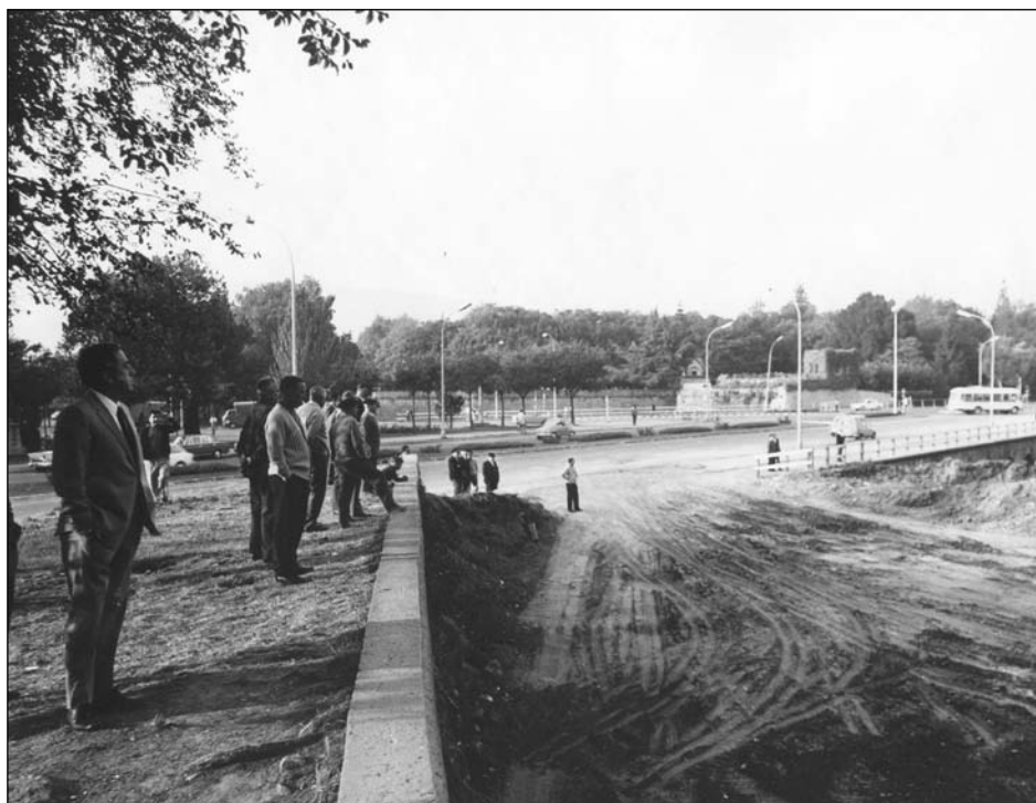
Figura 11. Labores de relleno del foso de las murallas, año 1971 (AMP, foto Galle)
