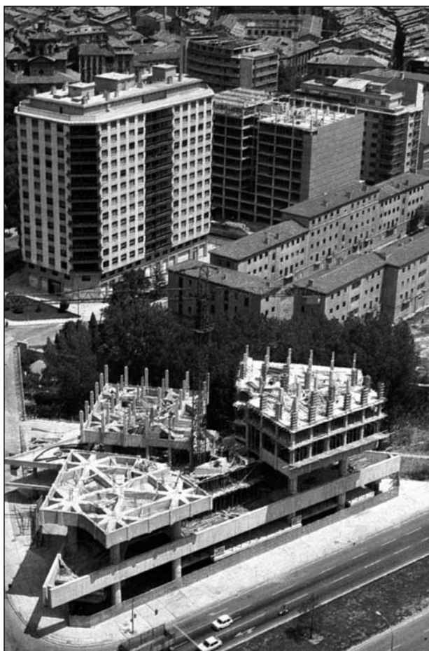
Figura 28. Estado de las obras de construcción del Edificio Singular, 19 de julio de 1973 (foto Paisajes Españoles)
