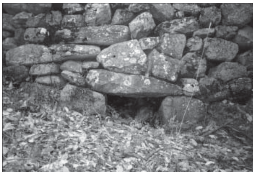
⊗ Cerca morisca con entrada de acequia. Almachar (Istán).
