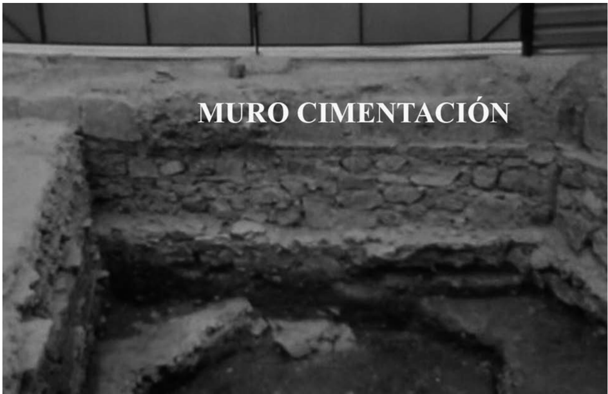
Figura 5. Muro de cimentación de tabaire de la casa del siglo XVIII en el actual solar nº 8. (Foto: M. C. López Rosique y M. C. Berrocal Caparrós, adaptada por la autora de este trabajo).
