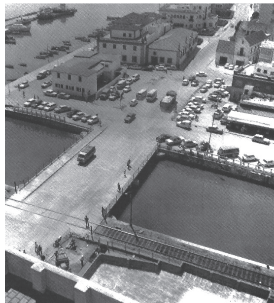
Lámina 19. Fotografía de 1972 donde se aprecian las zanjas de inserción de las riostras de hormigón. (Fuente: VVAA. 1993b).
