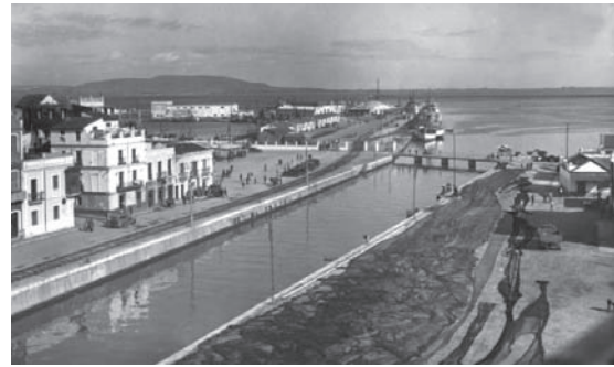
Lámina 18. Fotografía de 1930 donde se aprecia la fachada sur con el edificio del Café Tómbola y oficinas colindantes. (Fuente: VVAA. 1993b).
