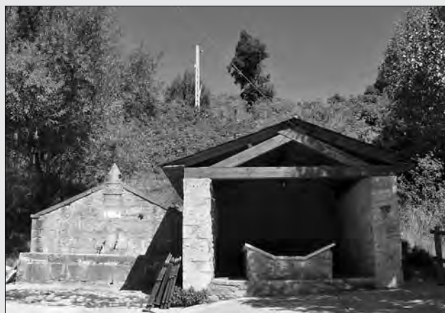
FUENTE Y LAVADERO DE TORRESTÍO. FOTO PEDRO PANIAGUA
