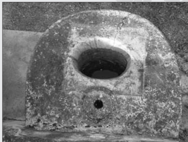
EL POZU DELANTE DE CASA EN CA 'L CANTU
