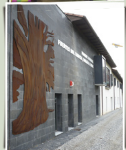
La Casa del Parque, en Corias, Cangas del Narcea, abierta desde finales de 2008, con oficinas y Centro de Recepción.
