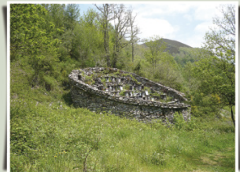
Cortín. Una estructura característica de la zona para la defensa de los colmenares vecinales de los ataques del oso.
