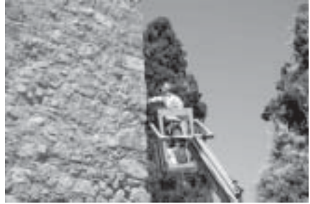
Castillo. Consolidación puntual de la esquina exterior del Lienzo 4
