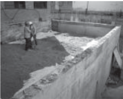
C/ Carrera de las Monjas, 3. Protección y soterramiento de estructuras arqueológicas pertenecientes a la villa romana
