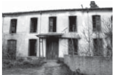
Molino de los Montoro, uno de los edificios destinados a la nueva sede del Museo
