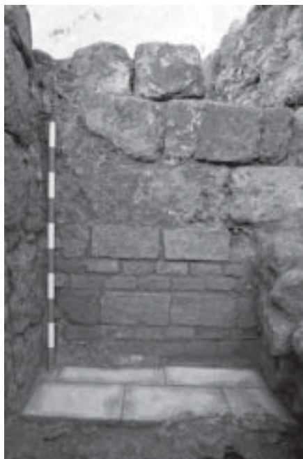
C/ Santa Ana, 6. Hamman andalusí. Pavimento de mármol y muro recalzado
