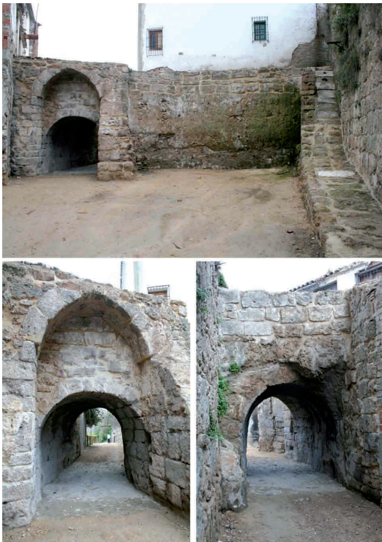
Lám. 6: La Puente Llovía , tras los trabajos de limpieza realizados en su entorno en 2007.
