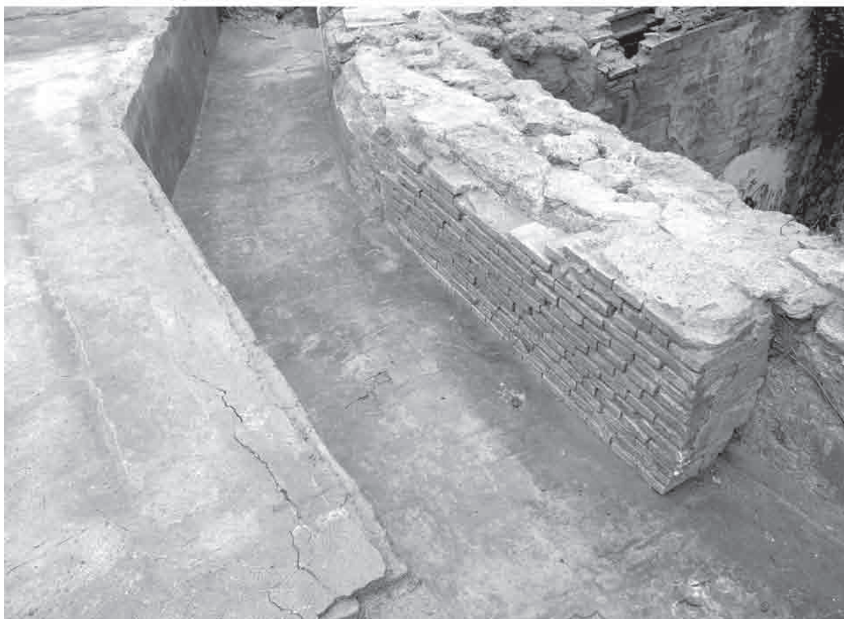
Lám. 7: Detalle del caz que discurre por la parte superior de la Puente Llovía tras la limpieza efectuada en 2007. En la fotografía superior no se aprecia un segundo canal que no fue limpiado y que pasa directamente sobre la parte central del paso abovedado, conformando una bifurcación en forma de Y.
