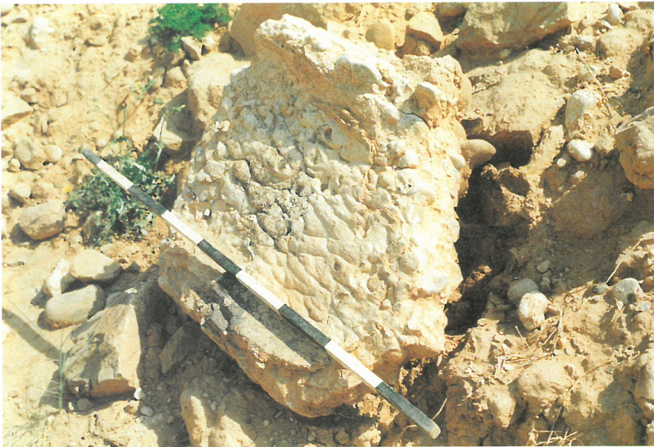
6.- Valroyo. Bloque de hormigón del suelo.
