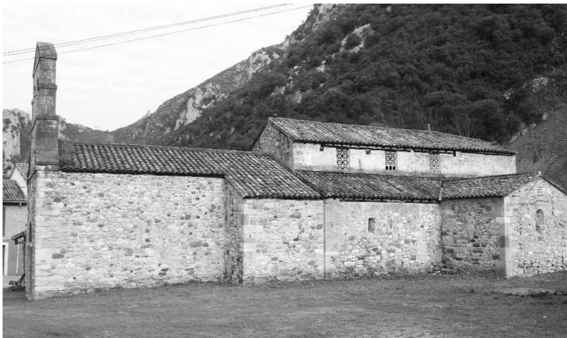
Fig. 1. Vista del costado sur antes de la restauración.
