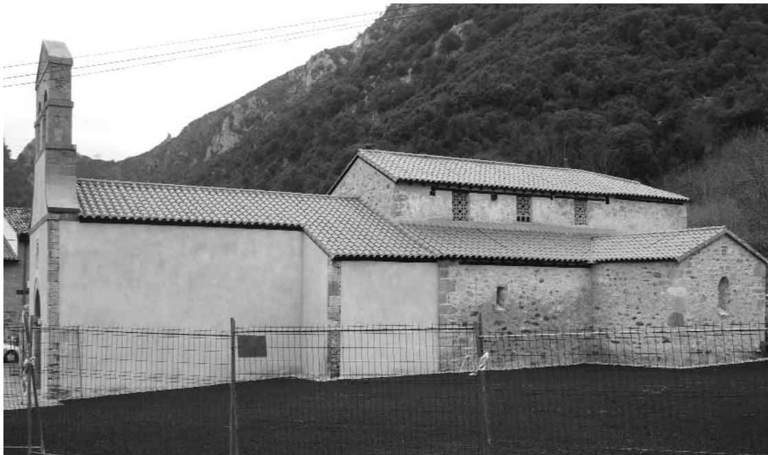
Fig. 2. Vista del costado sur después de la restauración.
