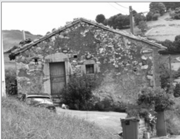
CASA EN EL SUCO DE TIPOLOGÍA ANTIGUA. J.I. PRIETO.
