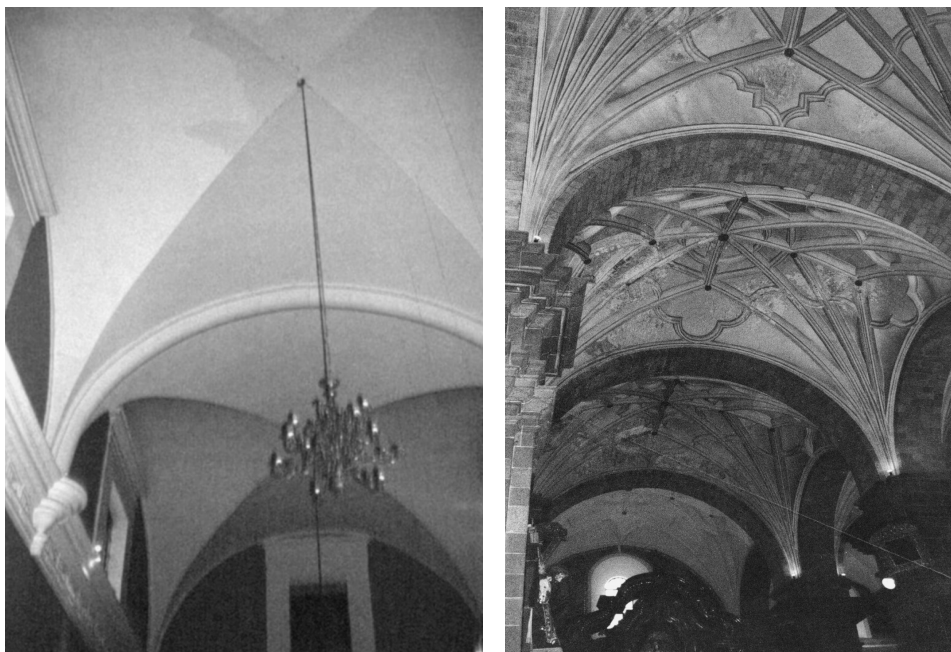
FIG. 10. A la izda., cubierta original de arista realizada por Becerra en la sacristía de la catedral de Lima. A la dcha., Bóveda de crucería de la nave central de la catedral de Cuzco.
