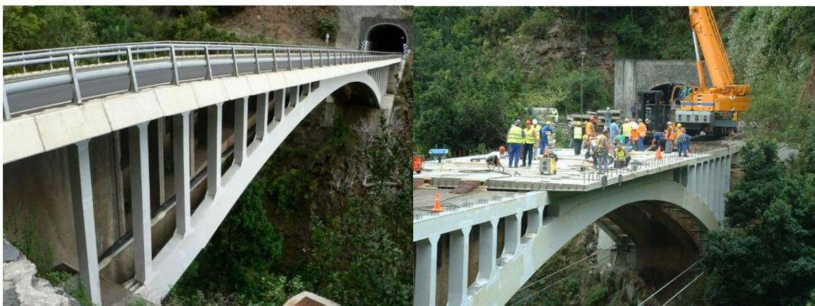
Fotos 13 y 14. Puente del Barranco de La Galga (La Palma). Construido sobre el puente de hormigón existente que se puede observar en su interior (izqda. foto Ignacio Español Echániz), las estructuras laterales y la plataforma lo envuelven (dcha. foto de José Tomás Rodríguez de Paz) aprovechando el trazado de la carretera y su túnel evitando así una actuación mayor.
