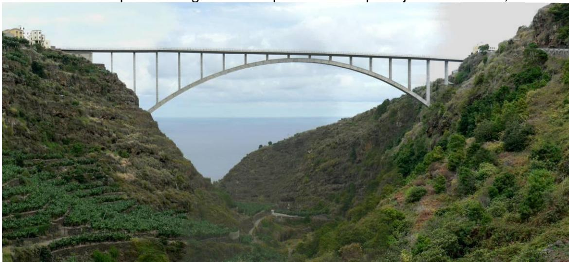
*Foto 2. El arco del viaducto de Los Tilos, en Los Sauces (La Palma) descarga el peso sobre las laderas Barranco del Agua con un espectacular desarrollo simple y geométrico, en contraste con los rasgos orgánicos del vano en el que se sitúa (foto Ignacio Español Echániz).*
