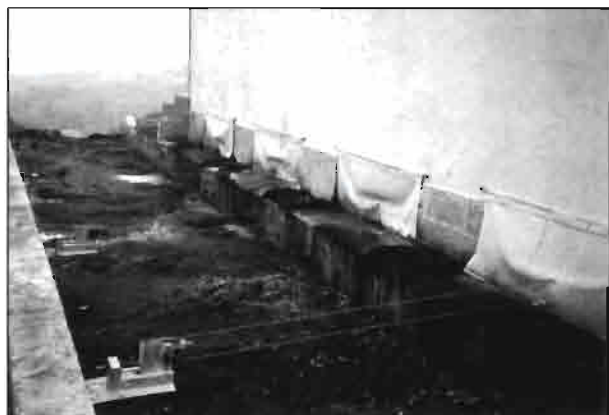
Sistema de salida de las palas mecánicas.
