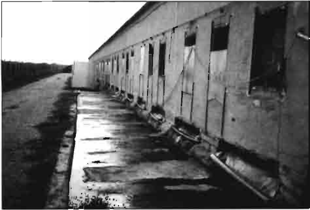
Evacuación directa al exterior por cinta transportadora.
