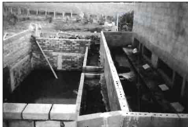
Fosa de decantación y estocaje de purines.
