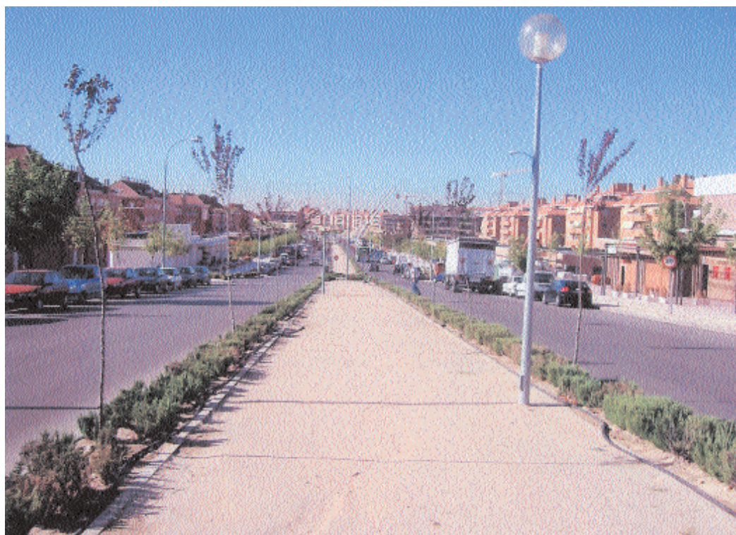
Figura 26: Imagen de un bulevar-avenida en Boadilla-oeste, con las edificaciones comerciales exentas en primer plano y los pequeños bloques exentos en parcela privada detrás.
