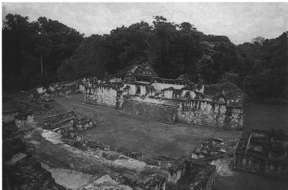
FIG. 5.—La Estructura 5D-46 en la Acrópolis Central de Tikal, Guatemala.
