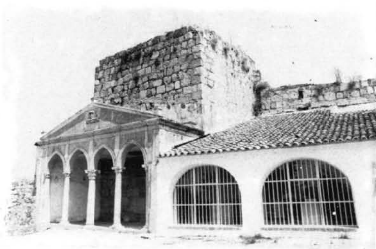
MÉRIDA. Torre de la Pólvora en el muro que separa la fortaleza del interior de la alzacaba.
