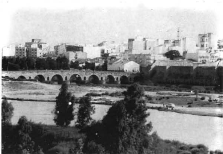
MÉRIDA. Puente romano y ángulo oeste de la alcazaba.
