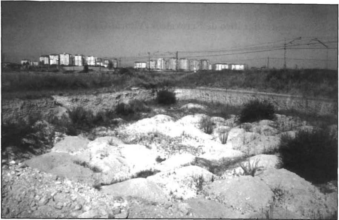
Foto 2. Estado actual de la cantera: vista parcial de los cortes W (a la izquierda) y N (a la derecha) y relleno de escombros.
