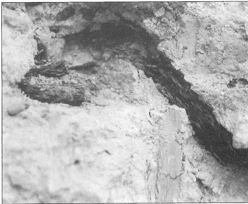
Restos orgánicos conservados entre la fábrica de la torre (madera y cuerda).
