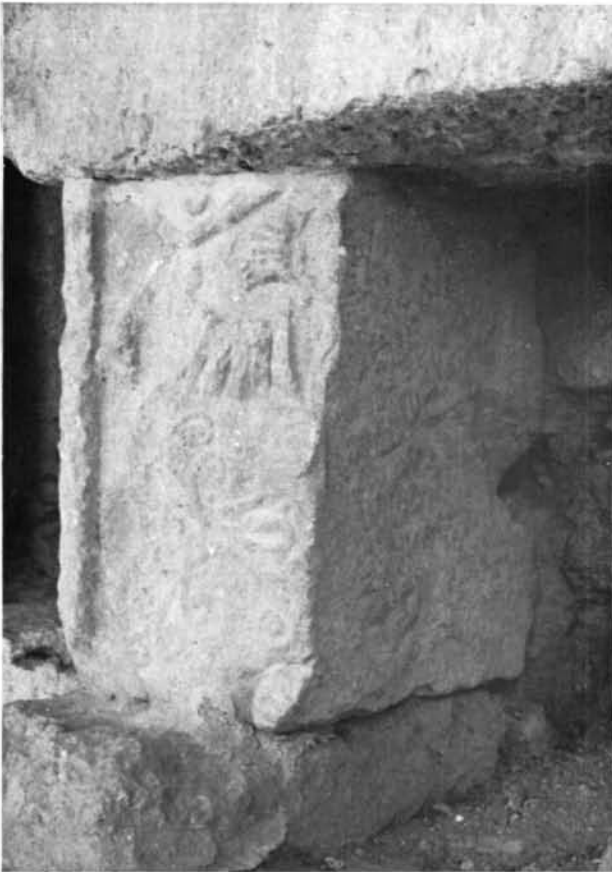
1. Santa María del Rivero. Aspecto del fragmento A. Obsérvese en una de las superficies visibles las huellas de ensamblaje para la colocación original de este sillar esculpido.— 2. Véase a la derecha la cara inferior del mismo fragmento.
