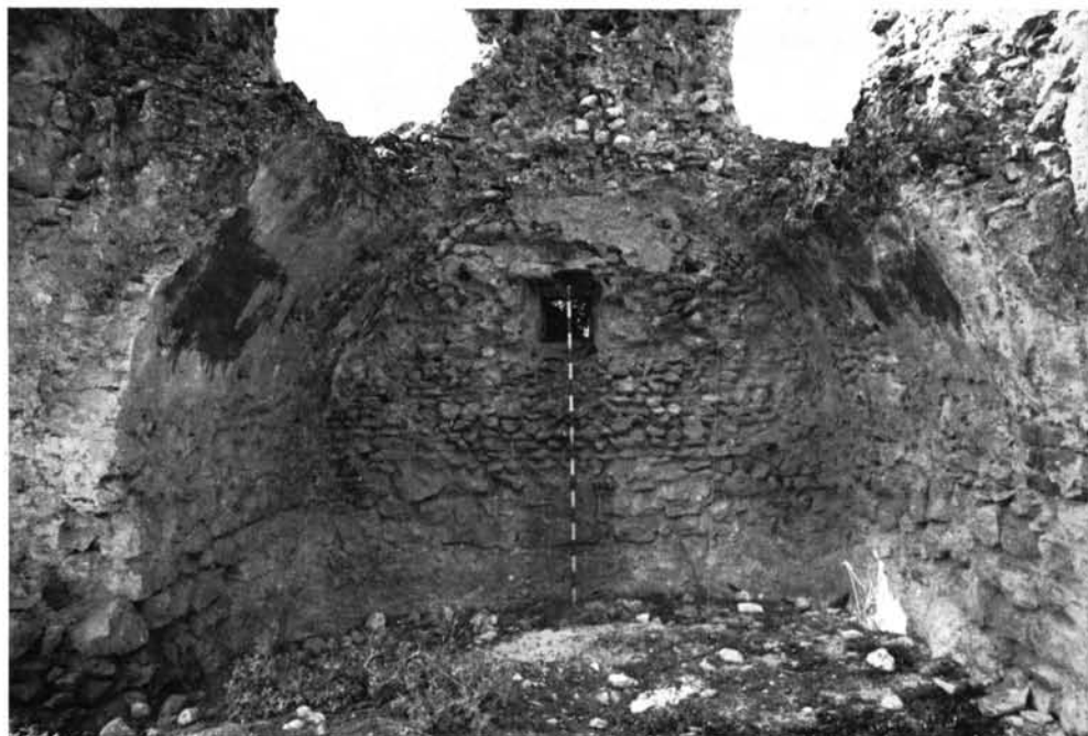
Sepulcro hispanorromano de Vildé. 1. Detalle del lado oriental. En primer plano la escalera del ángulo NE. derrumbada y en posición invertida por el arrastre de las riadas.—2. Interior del conditorium de la planta baja. Obsérvense las manchas oscuras a ambos lados de la bóveda, con restos de estuco pintado.
