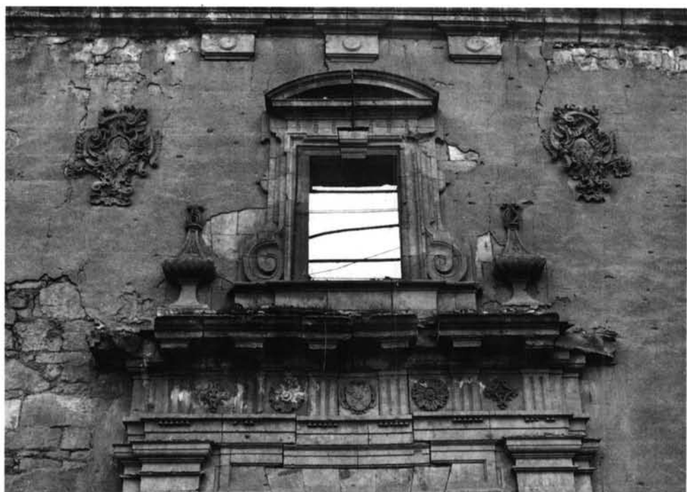
Salamanca. Iglesia de San Blas. Vista general del exterior y detalle de la portada.
