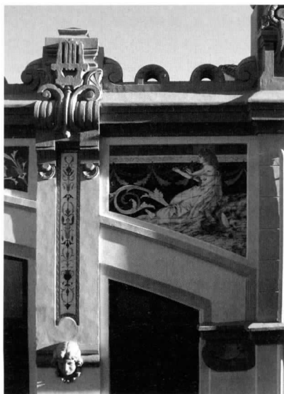
Los vanos superiores de la fachada principal se enmarcan por un arco rebajado que se recorta superiormente con cerámica vidriada decorada
