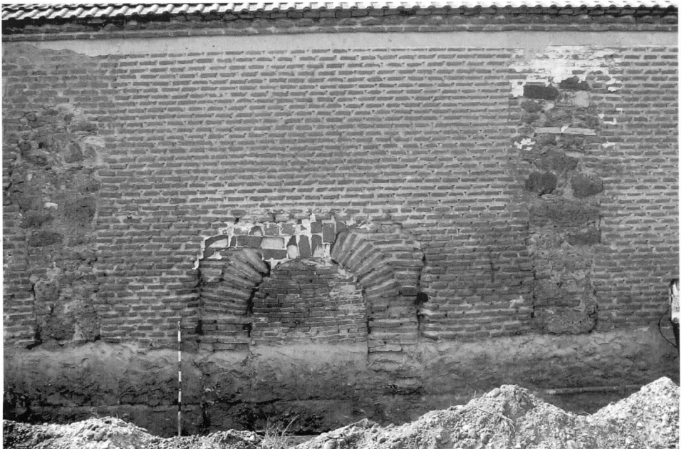
LÁMINA 2. Puerta en fachada norte
