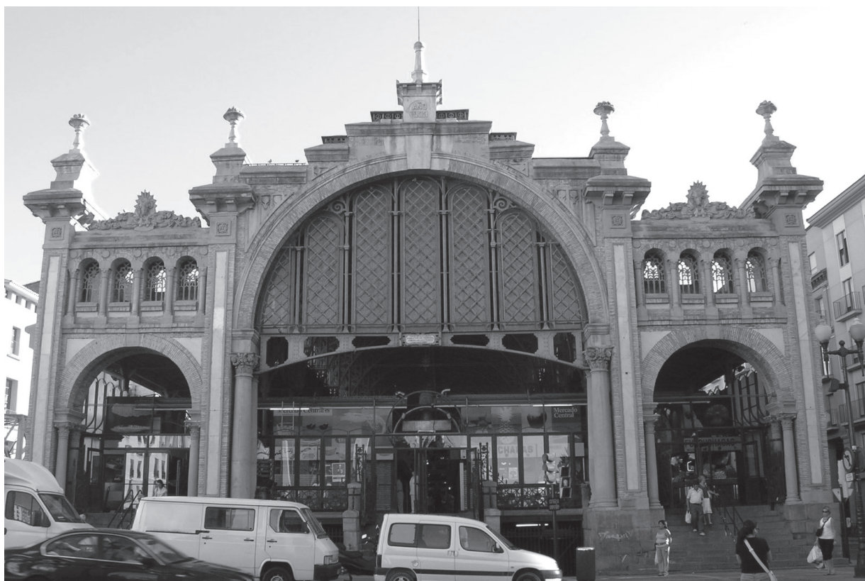
Lám.2: Mercado de Zaragoza, que ha sobrevivido recuperando su función comercial (autor).
