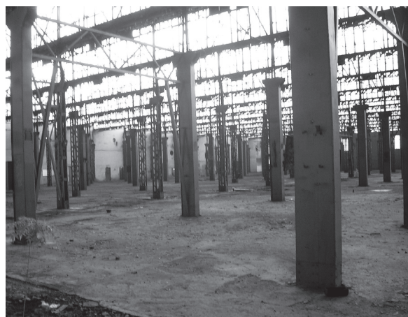
Lám.4: Antigua nave de Construcciones Electromecánicas (SECEM-CENEMESA, Córdoba); uno de los espacios industriales cordobeses con mayor potencialidad para su reutilización, condenado a la desaparición (autor).
