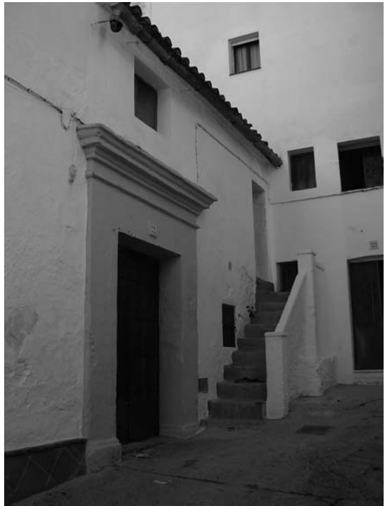
6. Vivienda en Avenida de Andalucía, Adarve. (foto F. Márquez)
