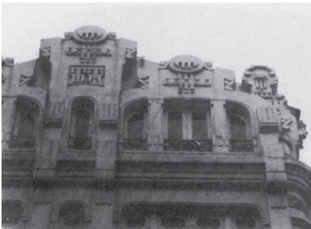
Fig. 3. Julio Galán. Casa de la plaza de Lugo, 24-25-26. Detalle de la fachada.
