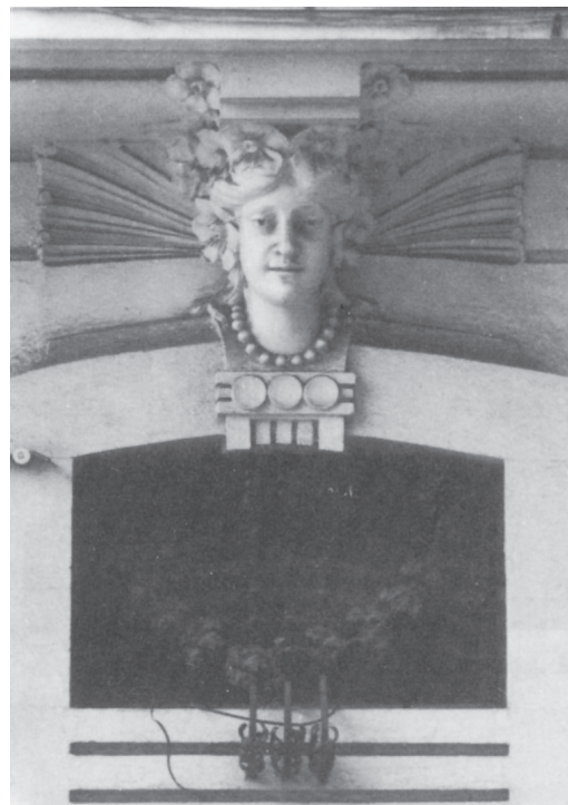
Fig. 8. Julio Galán. Casa Rey. Detalle de la fachada.
