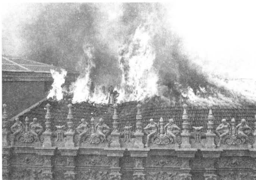
Fachada de la calle Burgos durante el incendio.
