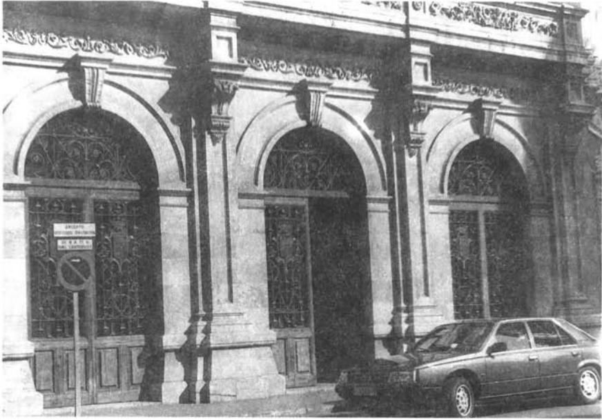
Fachada principal. Detalle de la puerta.
