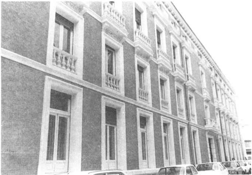
Vista general fachada calle Berruete.
