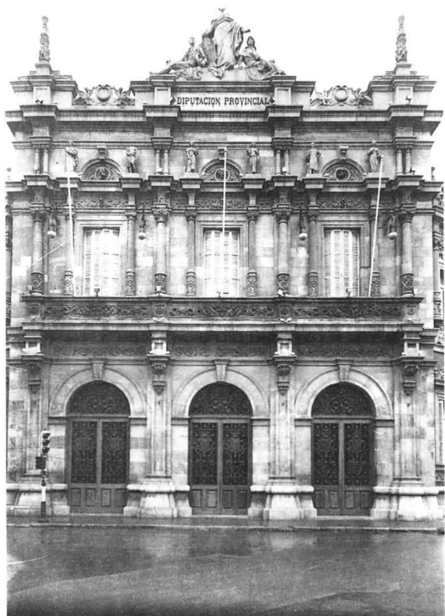
Fachada principal. Vista general.
