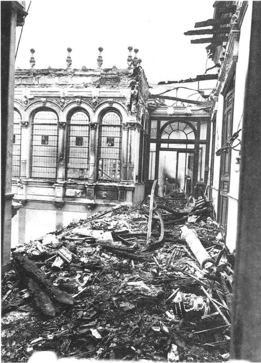
Estado en que quedó la parte principal de la galería.
