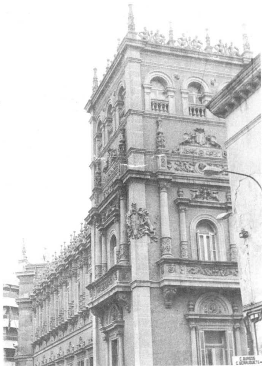
Torre de la esquina de las calles Burgos y Berruete.
