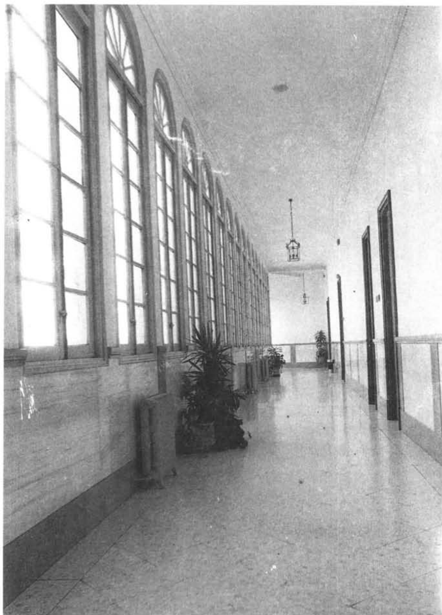
Perspectiva de la galería de la planta superior.
