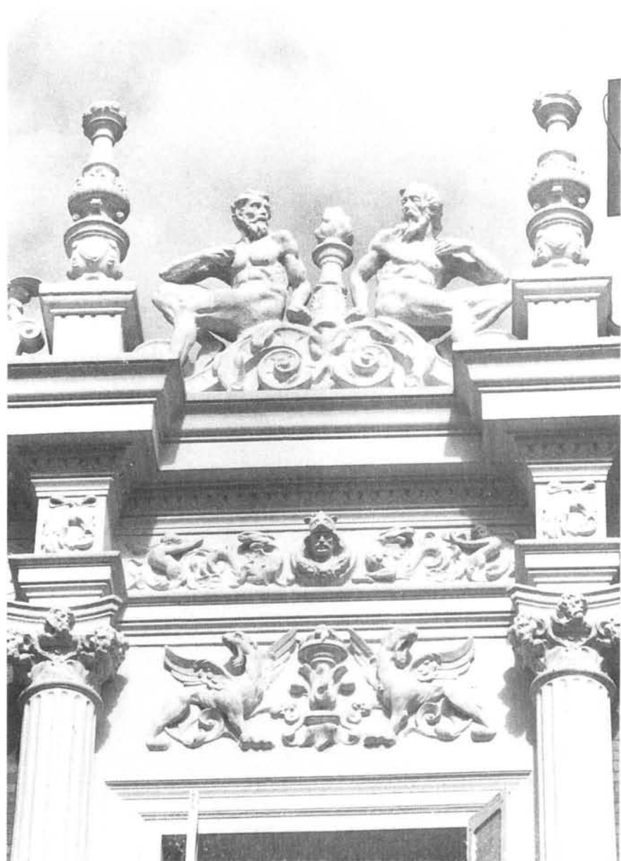
Remate de la ventana superior y crestería.
