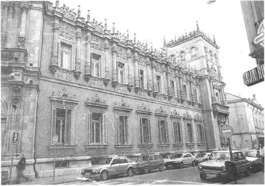
Vista general fachada calle Burgos.
