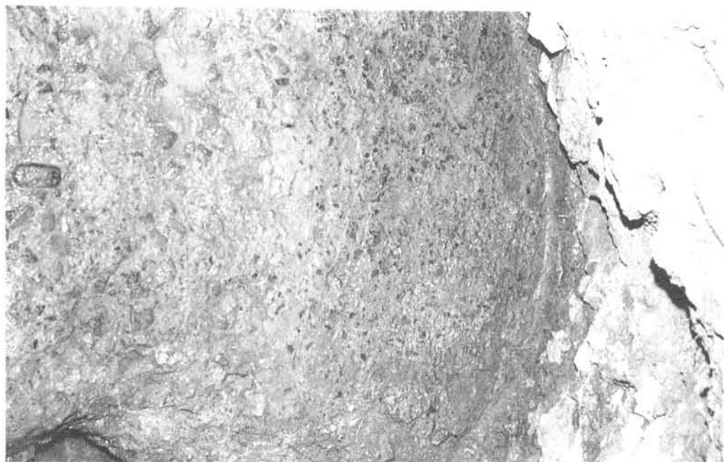
VALCAVADO -Hallazgos de pavimentación: Opus signinum. (Fotografía: J. María Caballero)
