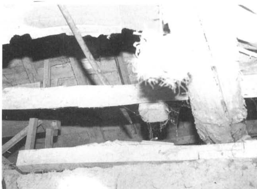
FOTO 5: Cubierta de una vivienda en San Román de la Cuba
