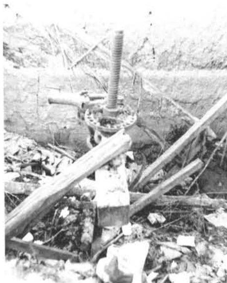
FOTO 15: Visualización de un lagar de una bodega en San Román de la Cuba, actualmente en ruinas.
