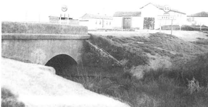
FOTO 26: Puente a la entrada de Arroyo.
