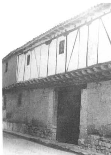
FOTO 6: Entramado localizado en Frechilla
