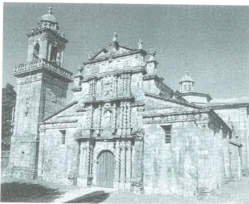
Vista general de la iglesia
