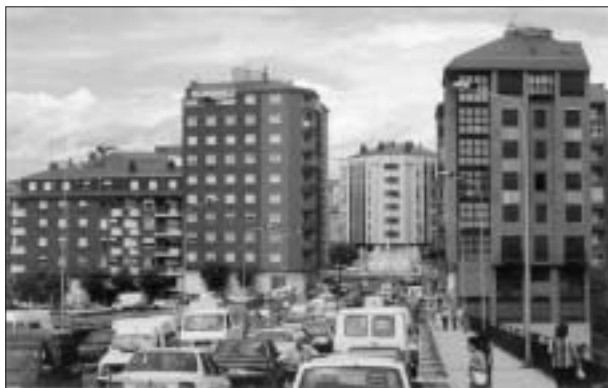
FIG. 5. Presión edificatoria sobre la avenida del Castillo.
